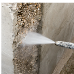
Podlago očistite z visokotlačnim čistilnikom.
