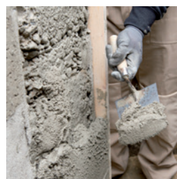
Neravnine izravnajte z malto iz programa Betonprotekt RTF, RT ali F .
