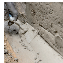
Na stiku temelja/stene se izdelata zaokrožnica z izdelkom Hidrostop Kit .
