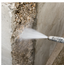
Podlago očistite z visokotlačnim čistilnikom.
