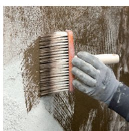
... grundiranje s pomočjo krtače ali valjčka
