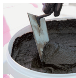
... po sušenju nanos lepila za izolacijske plošče ...
