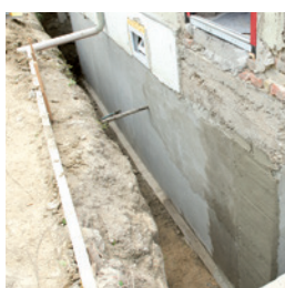
Ravnanje in glajenje z mineralnimi maltami
